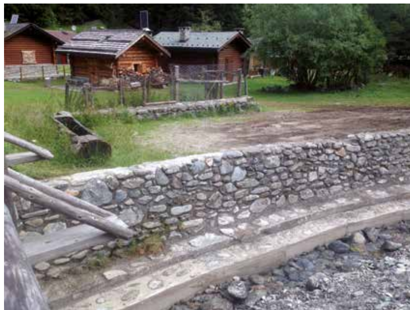
Valli di Sant'Antonio. Lavori di realizzazione di difese spondali ittocompatibili per il consolidamento delle sponde.
