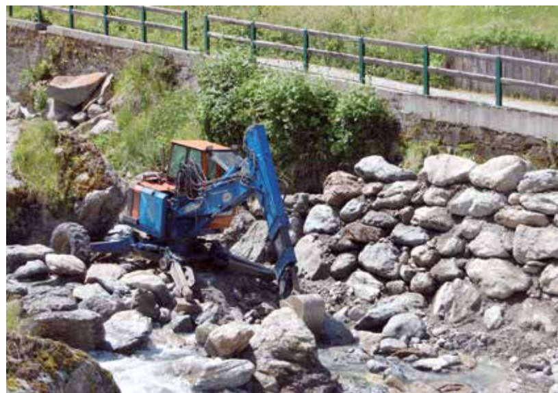
Valli di Sant'Antonio. Lavori di realizzazione di difese spondali ittocompatibili per il consolidamento delle sponde.
